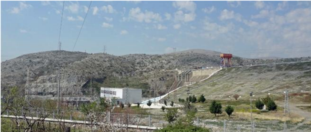
Figura 8: Diga e Vaut të Dejës turbina edhe nen-stacioni elektrik
